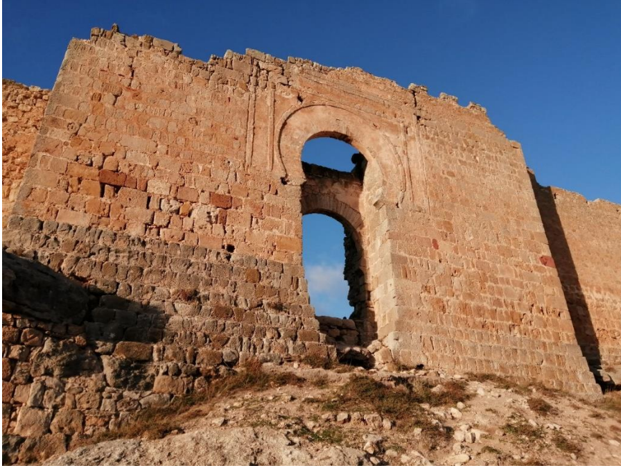
Figura 2. Vista exterior de la puerta califal de la fortaleza de Gormaz. Fotografía de los autores.
